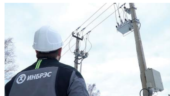
Установленное современное оборудование и комплексы телемеханики «ИНБРЭС» позволили реализовать алгоритмы распределенной автоматизации сетей — одной из базовых технологий Smart Grid
