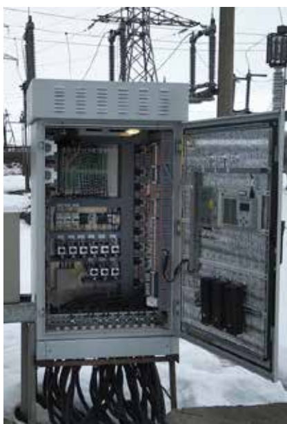
Рис. 2. Шкаф «ИНБРЭС-ШПДС» на ОРУ ПС 110/35/10 кВ («МРСК Сибири»)
