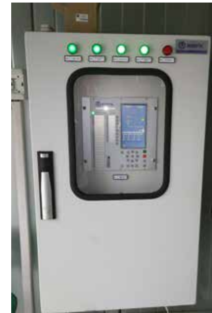
Рис. 3. Шкаф «ИНБРЭС-ШТМ» для ПС 35/6 кВ («МРСК Центра и Приволжья»)
